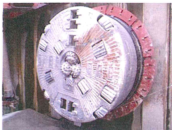
写真-4 掘進機到達状況
